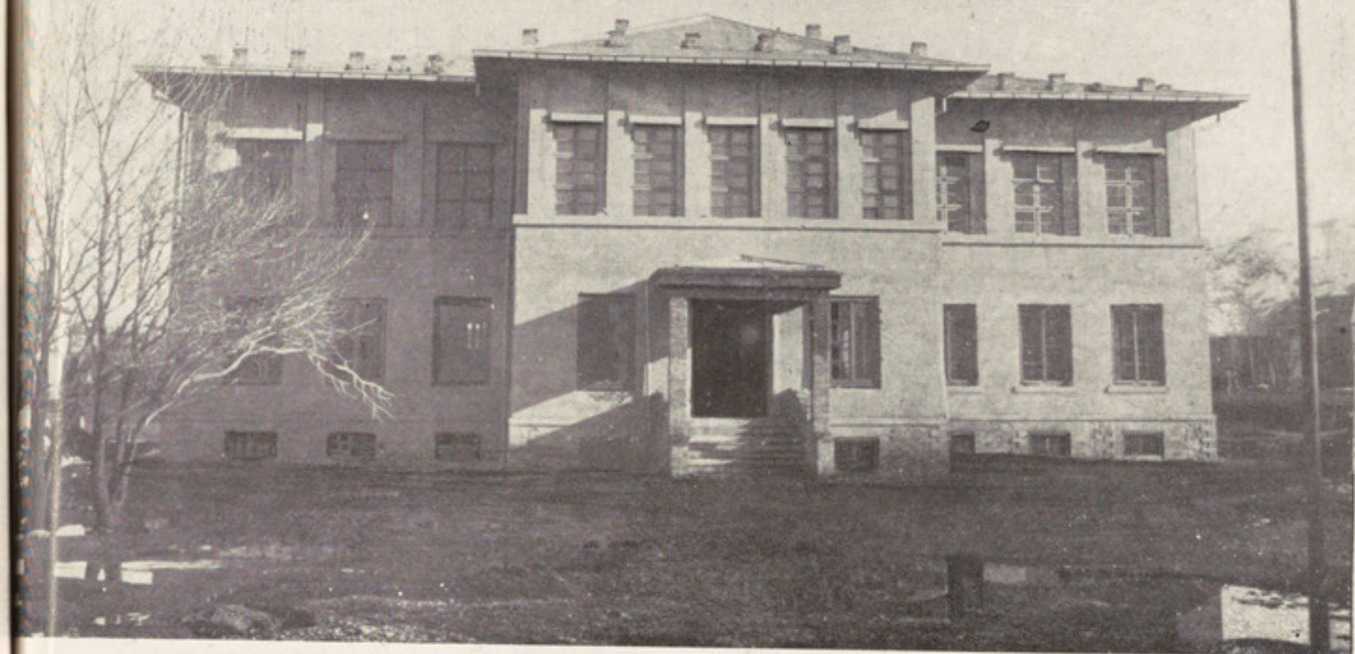
از ابنیه جدید وزارت معارف در کابل : عمارت تجربه خانه کیمیا که برای تجارب و تعلیمات محصلین مؤسسات طبی مرکز در جوار باغ عمومی ساخته شده و اکنون قریب اتمام است
